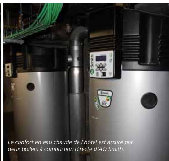
Les boilers à combustion directe sont une solution économique et performante en cas de forte demande d'eau chaude.
