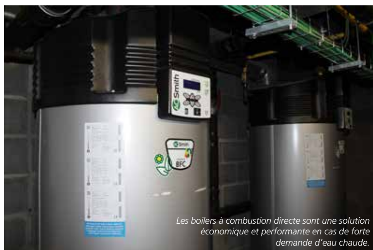
Le confort en eau chaude de l'hôtel est assuré par deux boilers à combustion directe d'AO Smith.
